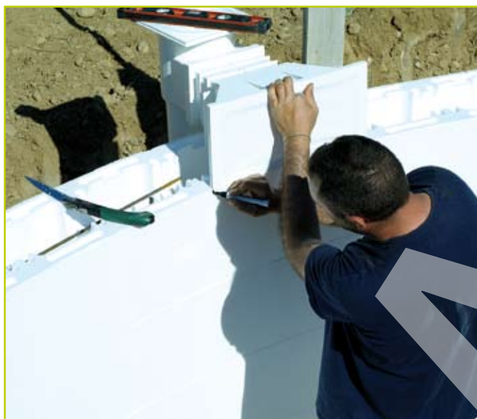
Posizionamento dei pezzi a murare-tracciatura della sagoma
