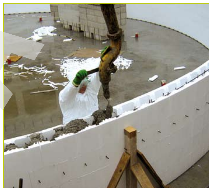
Getto del calcestruzzo
