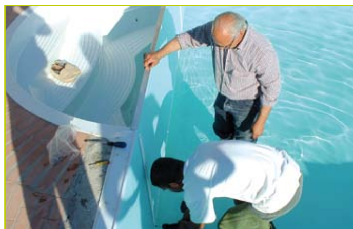
Fissaggio dei pezzi speciali- scala in vtr
