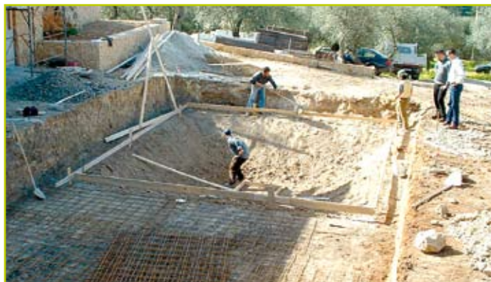
Stesura delle reti elettrosaldate
