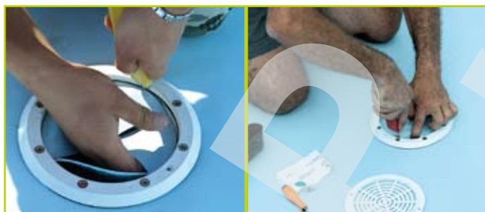
Fissaggio dei pezzi a murare-rimozione del liner in eccesso
