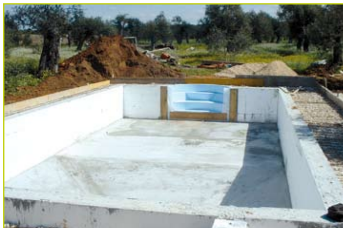
Getto di cemento completato
