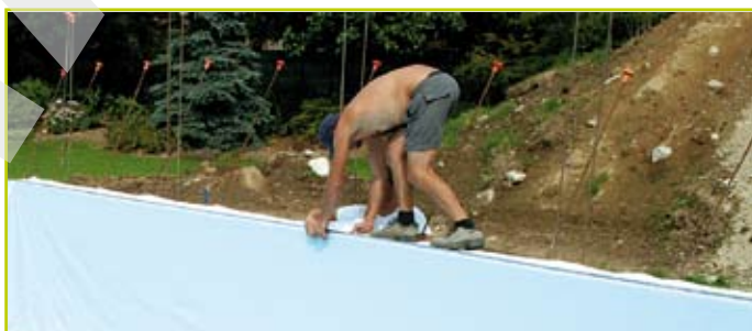
Fissaggio del liner alla guida
