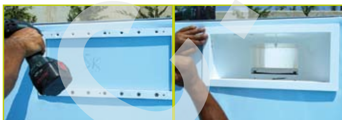
Fissaggio dei pezzi a murare
