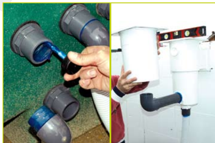
Fissaggio dei raccordi
