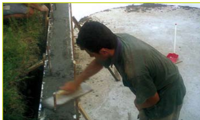
Livellamento della superficie
