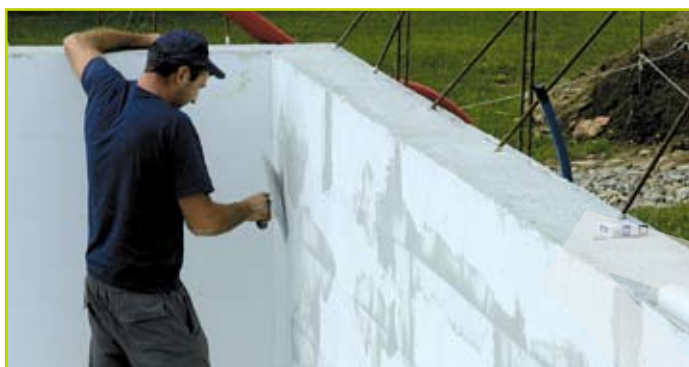
Stuccaggio imperfezioni eventualmente derivanti dalle lavorazioni in cantiere
