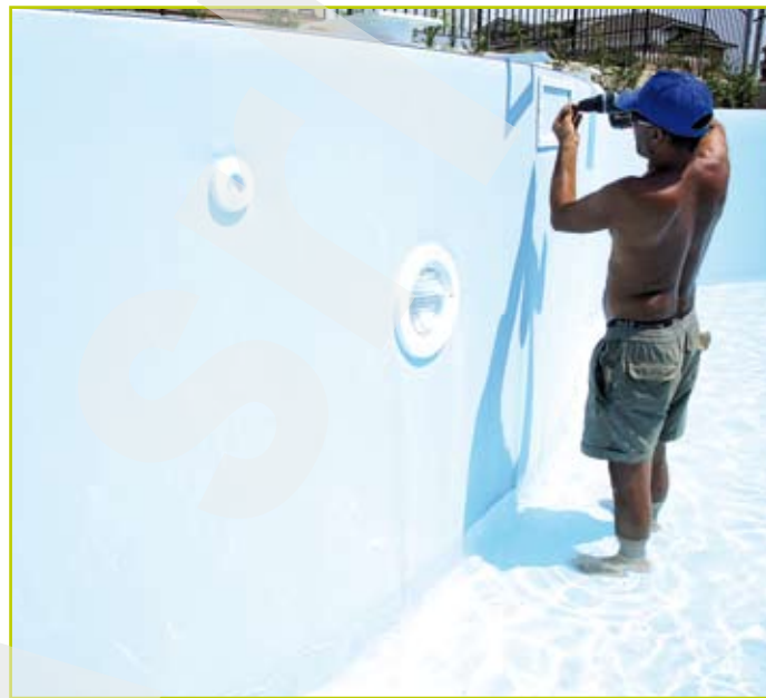
Fissaggio dei pezzi a murare
