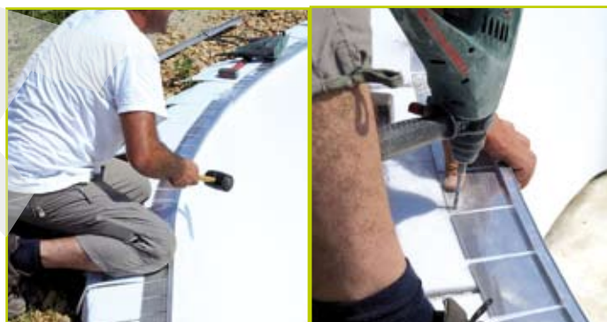
Operazione di posa e fissaggio della guida in alluminio
