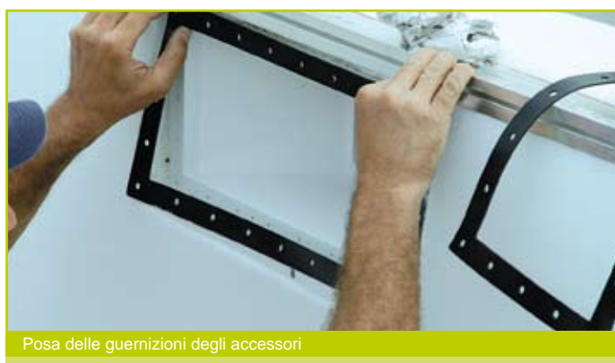
Operazione di posa e fissaggio della guida in alluminio
