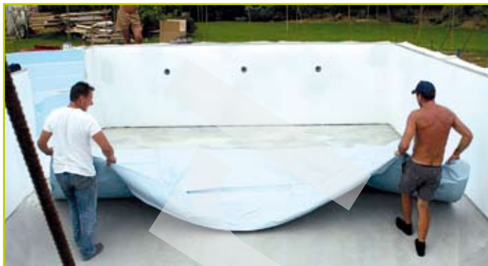
Stesura del liner
