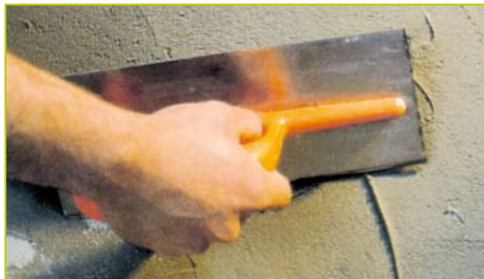
Livellatura del calcestruzzo
