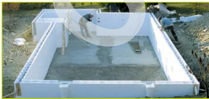
Posa dei casseri ISOBLOK
