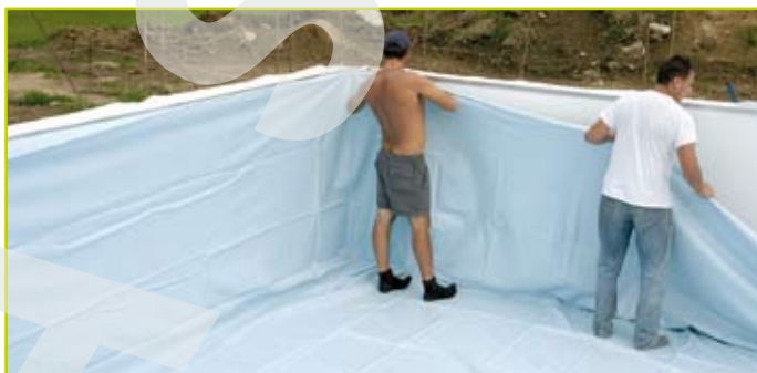
Fissaggio del liner agli angoli
