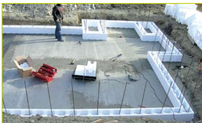
Posa dell'armatura verticale delle pareti perimetrali
